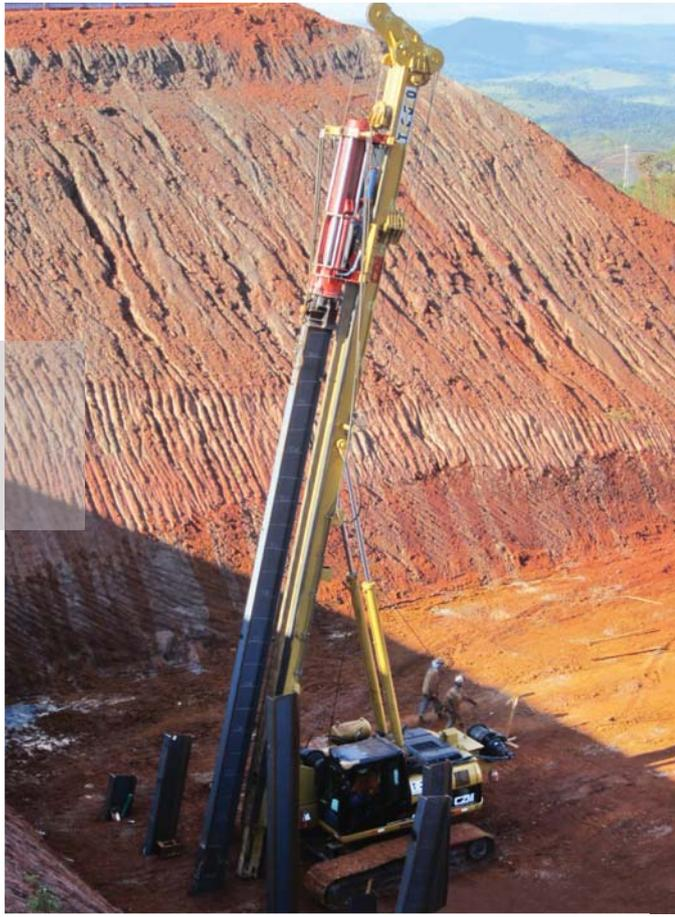
Cravamento inclinado 14° / Driving batter piles up to 14°
