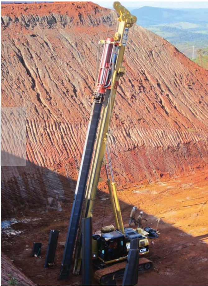
Cravamento inclinado 14° / Driving batter piles up to 14°
